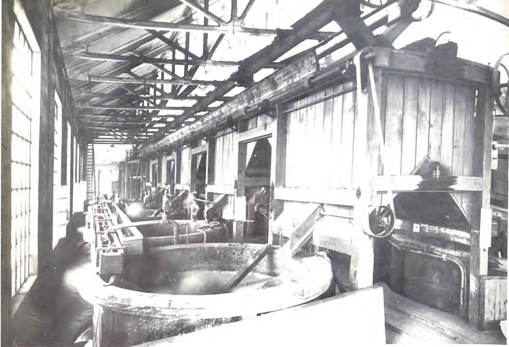
Monteponi - Impianto per lo zinco elettrolitico: tino Pachuca per la lisciviazione dei minerali.
